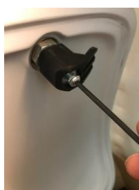
Povoliť skrutku imbus kľúčom 3mm
